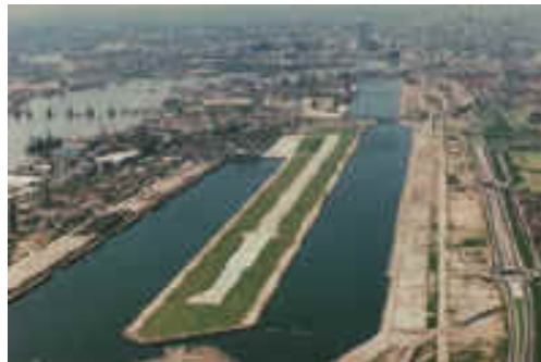
Figura 1-1 – Vista área do aeroporto de London City (Inglaterra)
