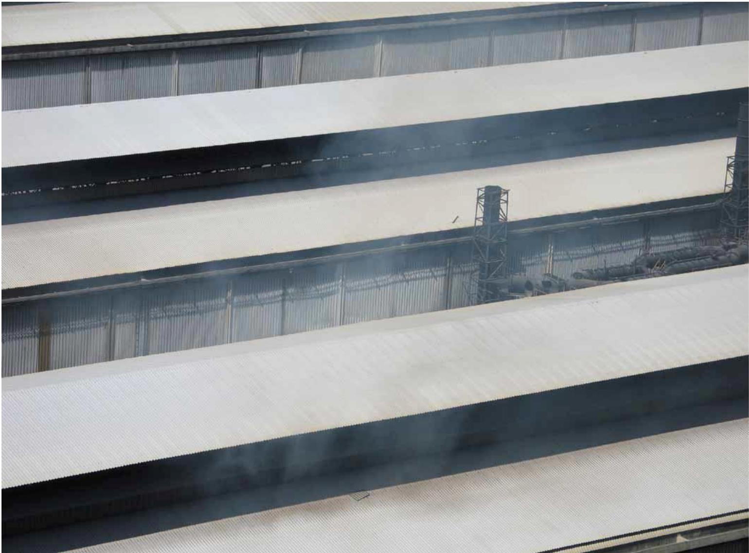
A fundição nas cubas de eletrólise desprende gases carbônicos inclusive CO, hidrocarbonetos em parte queimados em chamas piloto na saída dos gases, mais gases fluorídricos (fluoretos) e fumaça e poeira, em maiores quantidades quando há instabilidades dos fornos.
