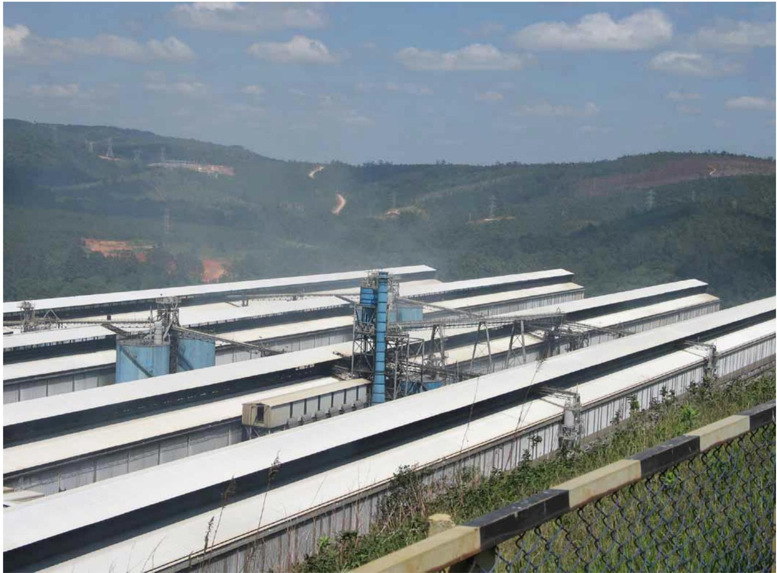
Redução eletrolítica do alumínio 2a. Etapa de ampliação, capacidade produtiva instalada na CBA total de **400 mil ton anuais em out 2006**
