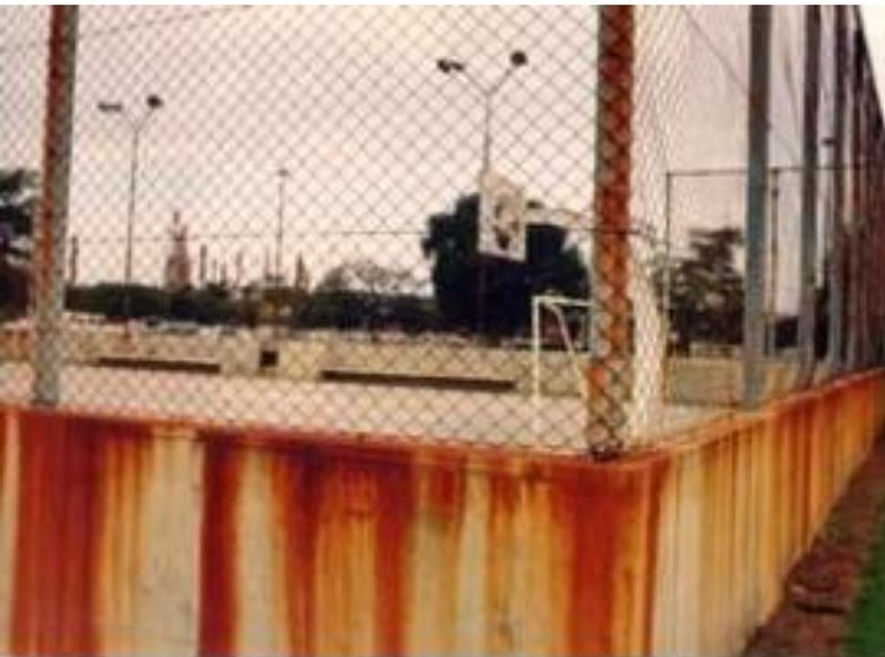
**Figura 8- Corrosão atmosférica**
