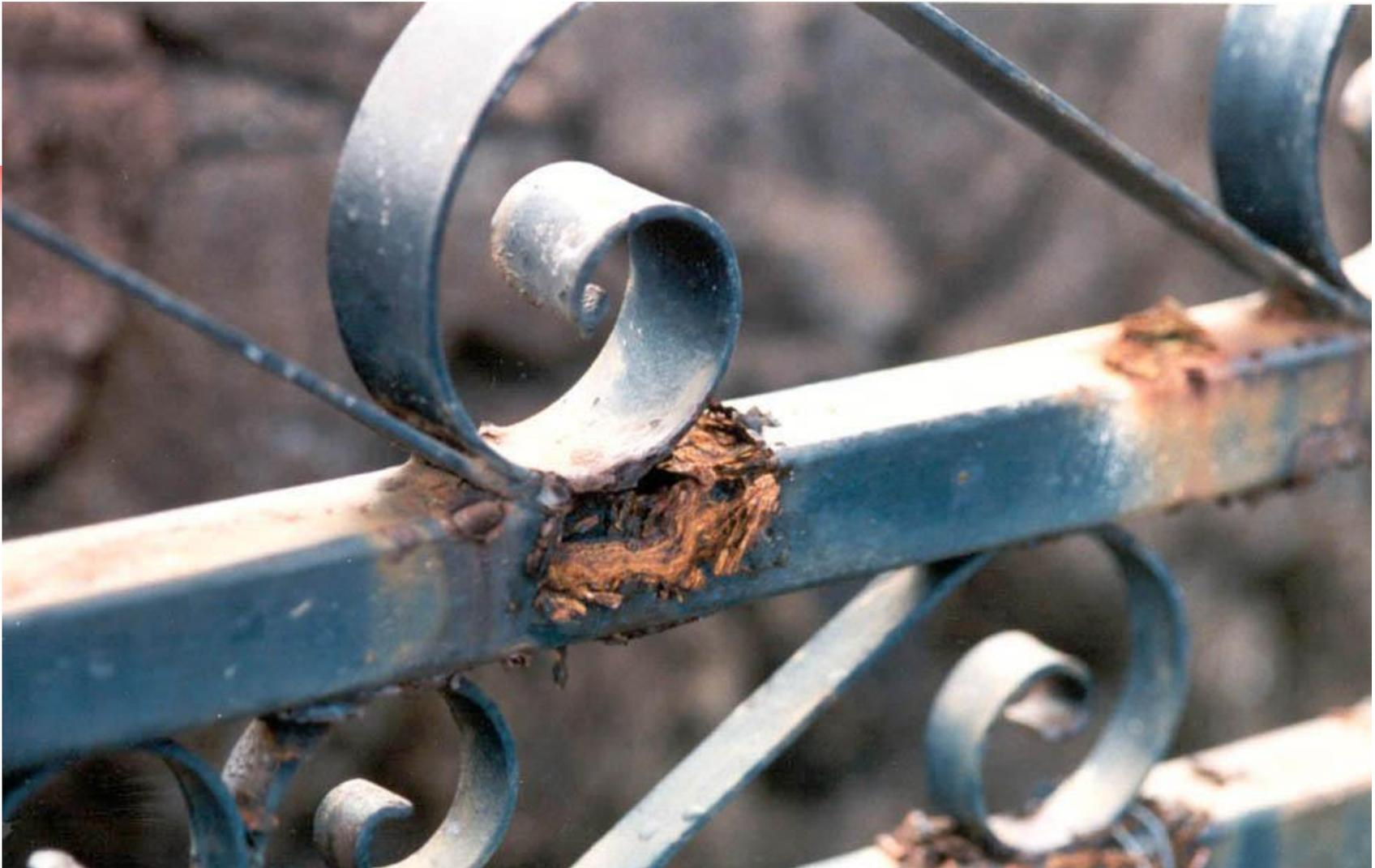
**Figura 3- Corrosão em um sistema de solda**
