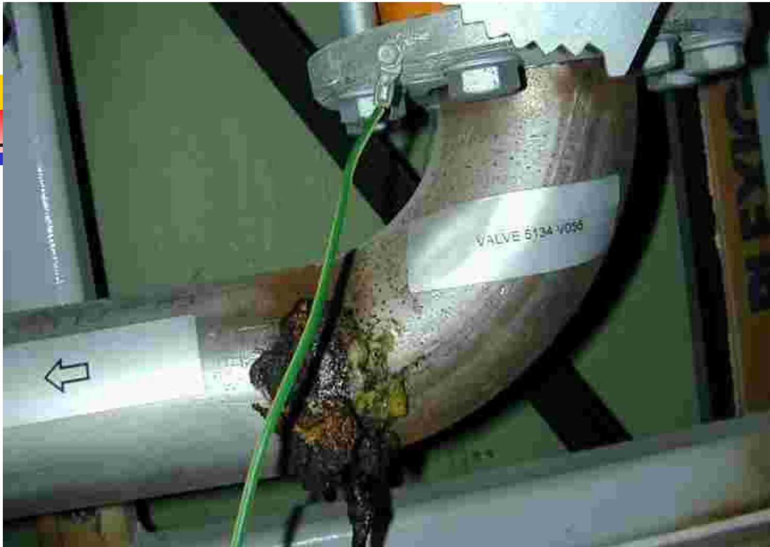
**Figura 2- Corrosão em uma tubulação**
