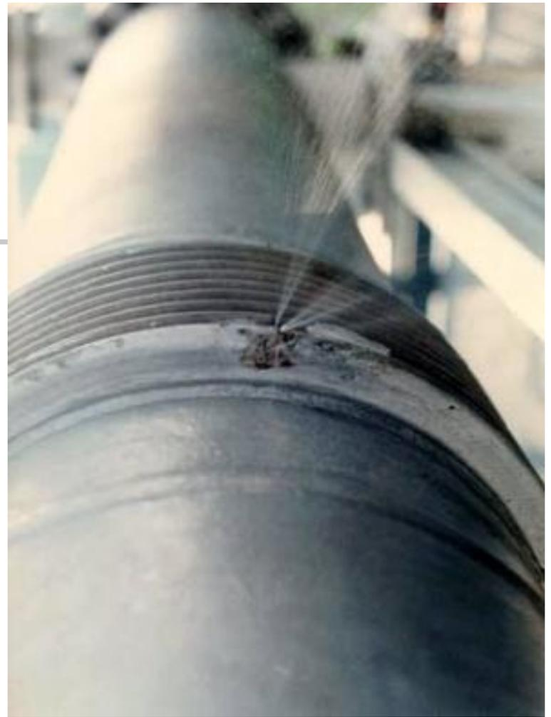
**Figura 5- Corrosão por fadiga em junta de expansão**
