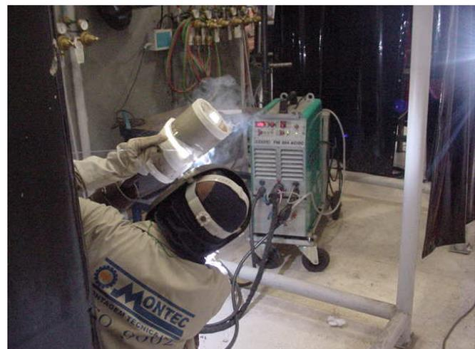
Cabine de Solda e posicionamento dos tubos na posição 6G.
