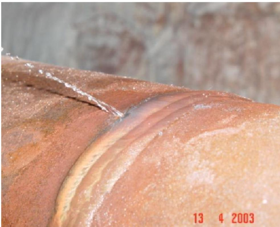
**Figura 2** – Vazamento no Tubo-17 solda-1 (tubo de 150 mm de diâmetro)
