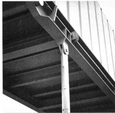
A estrutura mostrada na foto é sustentada por pinos colocados nas extremidades das colunas. (8)
