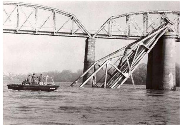
Fig. 9 Silver Bridge após colapso.
