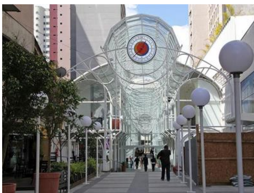
Figura 10: Entrada da Rua 24 h.
